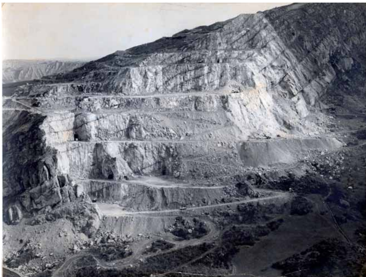
Fig. 3 – Cava di Monte Tondo: coltivazione a gradoni. Fotografia datata 28 febbraio 1962 (Archivio A. Olivier).
