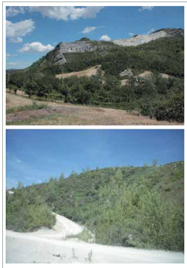
Fig. 22 – Discarica principale: paramento esterno. In alto: visione attuale del paramento esterno già ripristinato; punto di ripresa fotografica esterno all’area di cava. In basso: particolare del paramento esterno rinverdito; su questo versante sono state portate a termine operazioni di semina e piantagione manuale di essenze autoctone, accompagnate da una rinaturalizzazione spontanea (foto R. Margutti, 2011).
