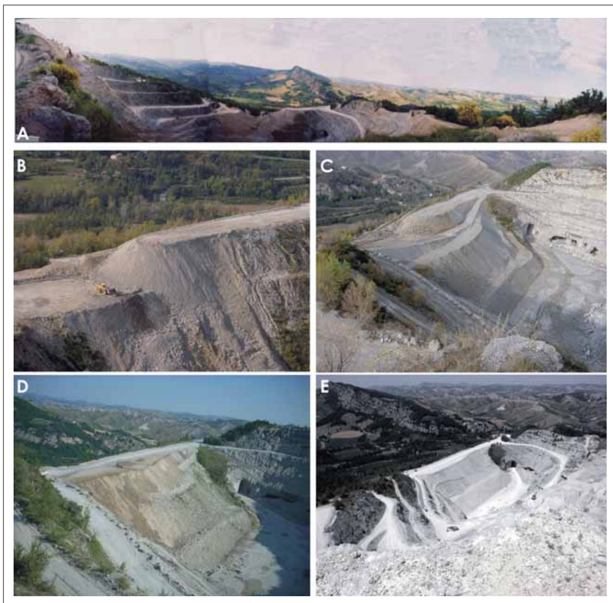
Fig. 21 – Discarica principale: paramento interno. A) Immagine panoramica della cava dai fronti di scavo orientali: al centro dell'immagine è visibile la discarica mineraria, costituita da due rilevati, come appariva nel 2004 (da FANTI 2004). B) e C) Stato dell'arte del paramento interno nel novembre 2006. D) Definitiva colmatazione della discarica mineraria realizzata nell'estate del 2010, con riduzione dell'impatto visivo dall'esterno. E) Visione attuale del paramento interno ancora da ripristinare e panoramica del versante occidentale della Valle del Senio; punto di ripresa fotografica dai fronti di ampliamento della cava (foto I. Zembo, 2011).
