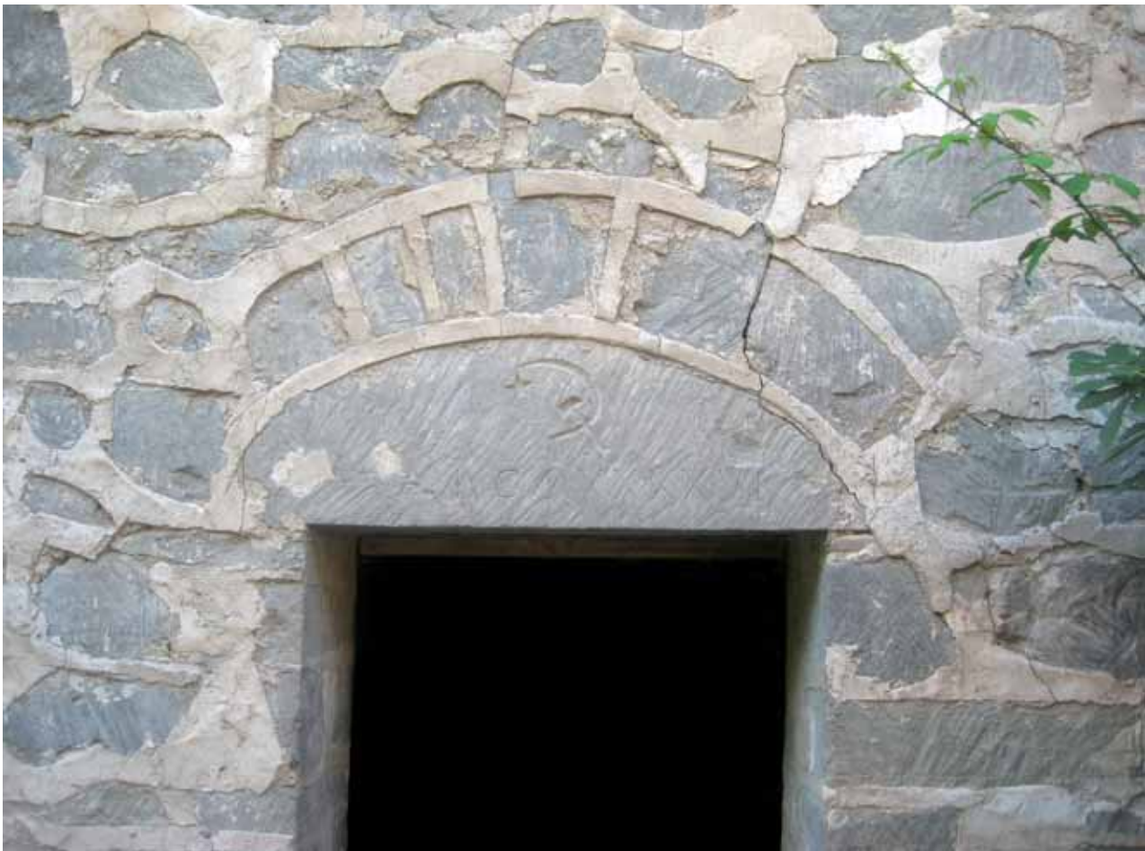
Fig. 15 – Ruederi di un edificio di servizio della fornace da gesso della Cooperativa Agricola di Riolo Terme, localizzata all'inizio della salita per Sassatello. L'architrave vede incise la data di realizzazione dell'impianto (1946), nonché, a riprova dell'ispirazione marxista della cooperativa, falce e martello (foto S. Piastra).
