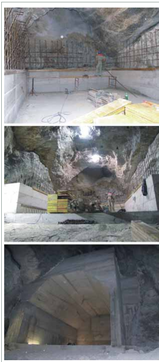
Fig. 27 – Messa in sicurezza del piano di calpestio della Grotta del Re Tiberio. In alto e al centro: fase di realizzazione della centinatura. In basso: opera terminata (foto R. Margutti).
