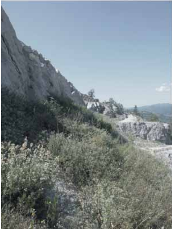
Fig. 23 – In alto: gradoni di cava in abbandono del fronte Ovest (punto di ripresa fotografica dal gradone di quota 370 m s.l.m.). I gradoni di quota 350 e 360 m s.l.m. sono collegati tra loro, verso Nord, da una rampa visibile sullo sfondo della foto. In basso a sinistra: cono di detrito rinverdito sul gradone di quota 360 m s.l.m. In basso a destra: sezione tipo del ripristino ambientale dei gradoni di cava (S.I.A. 2004; da FANTI 2010a) (foto I. Zembo, 2012).
