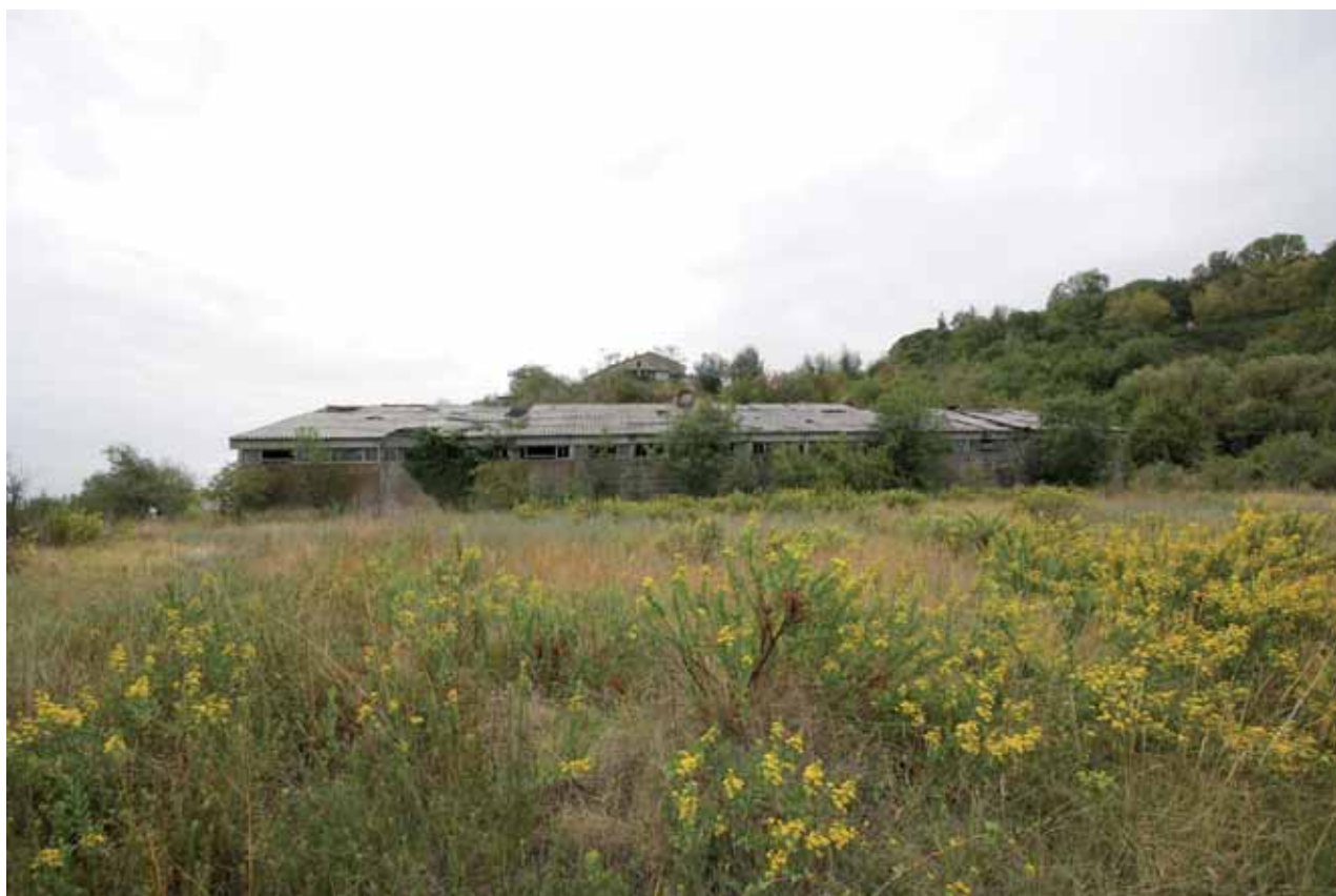
Fig. 3 – Il rudere della porcilaia a sud dei Crivellari (foto P. Lucci).
