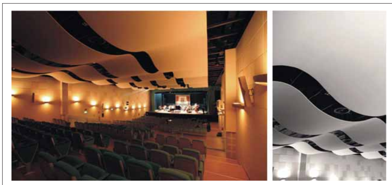
Fig. 11 – Immagine del recupero del Teatro Moderno progettato nel 1969 dall'architetto Locatelli all'interno del centro storico di Fusignano (RA). Il recupero è stato eseguito attraverso l'utilizzo dei sistemi a secco GYPROC Saint Gobain derivanti dal gesso estratto da Monte Tondo e trasformato nello stabilimento di Casola Valsenio. L'utilizzo dei sistemi a secco è risultato idoneo per ottenere un'alta resa estetica (come si può apprezzare nella foto dal controsoffitto “ad onda”) ed elevate prestazioni tecniche, come la resistenza all'umidità e agli agenti atmosferici, la massima protezione acustica e la riduzione delle sostanze nocive presenti nell'aria (da www.gyproc.it ).
